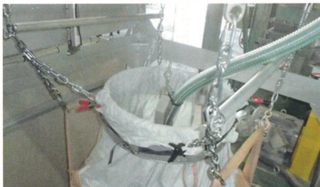
フレコン取付状態
